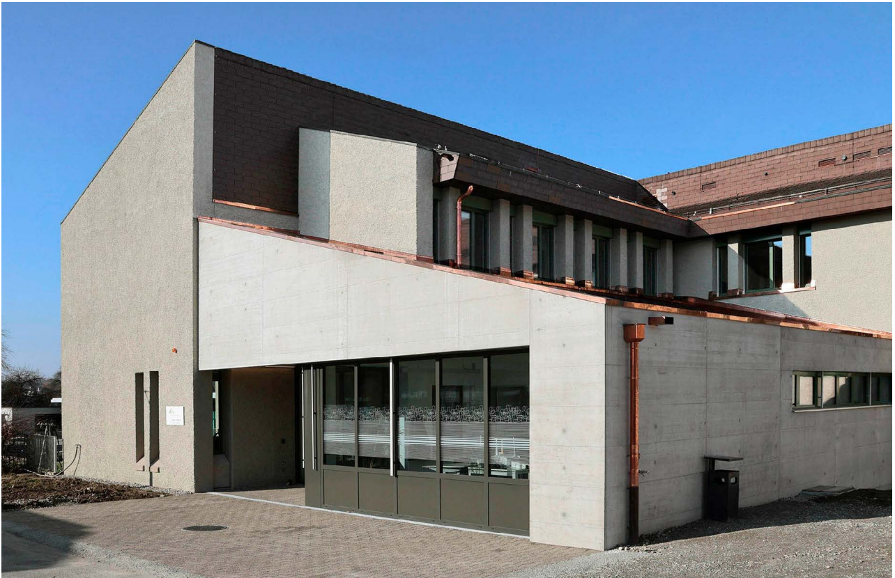
Das Mehrzweckgebäude (MZG) nach Abschluss der Sanierungsarbeiten.
